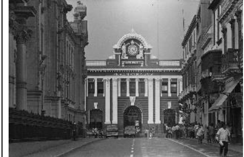
Vista de la Estación
