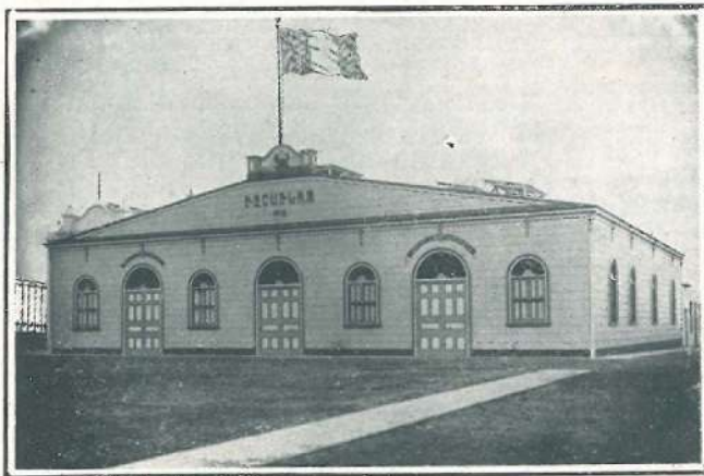
No. 2 - Vista exterior de los edificios de las escuelas.
