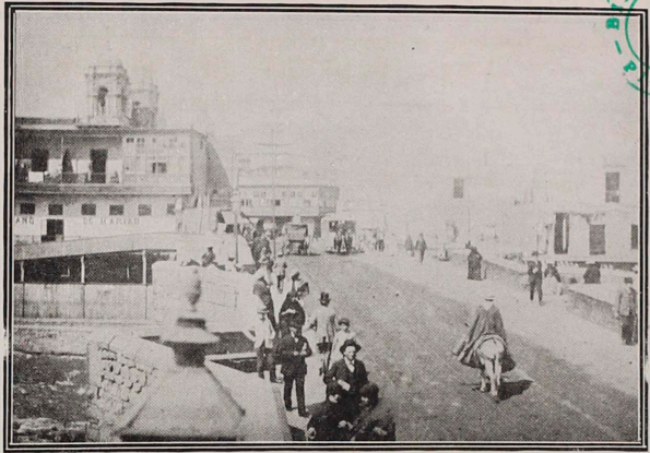
La Lima desaparecida.—La calzada del Puente
