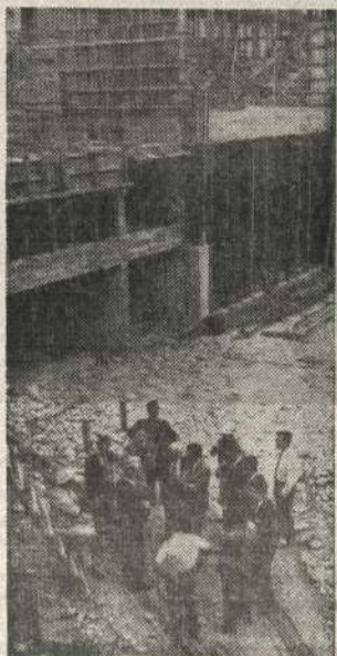
ESTADO EN que se encuentran las obras del nuevo Mercado Central que se construye en el mismo lugar del antiguo local destruido por un voraz incendio.
